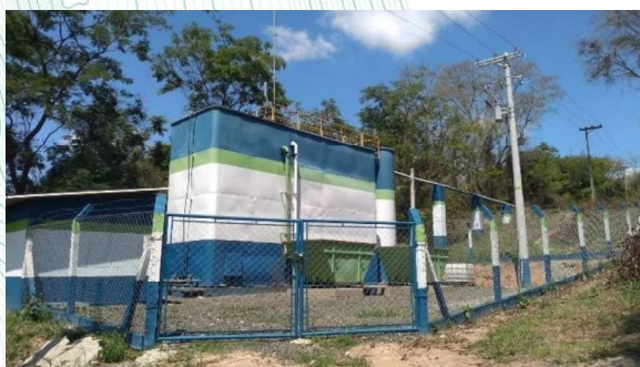
Figura 106 – Vista geral da unidade
