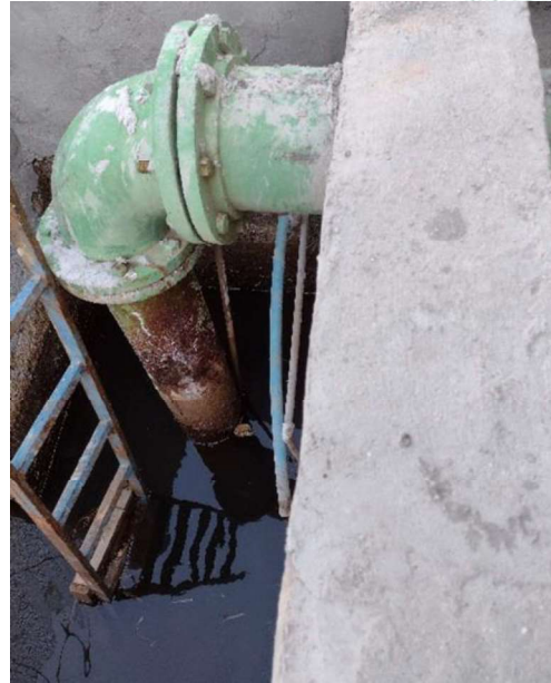
Figura 65 - Dosagem preliminar no poço.
