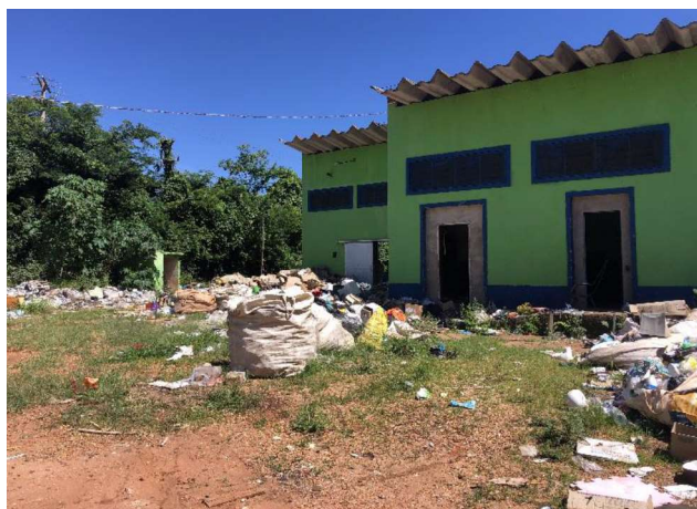
Figura 126 - Frente do galpão da Cooperativa Fonte: Amplar, 2021
