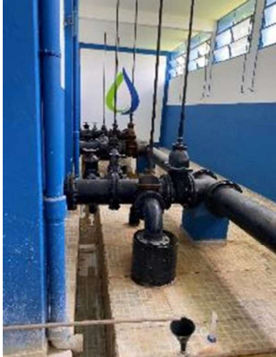
Figura 58 - Barrilete para comando da operação de filtração
