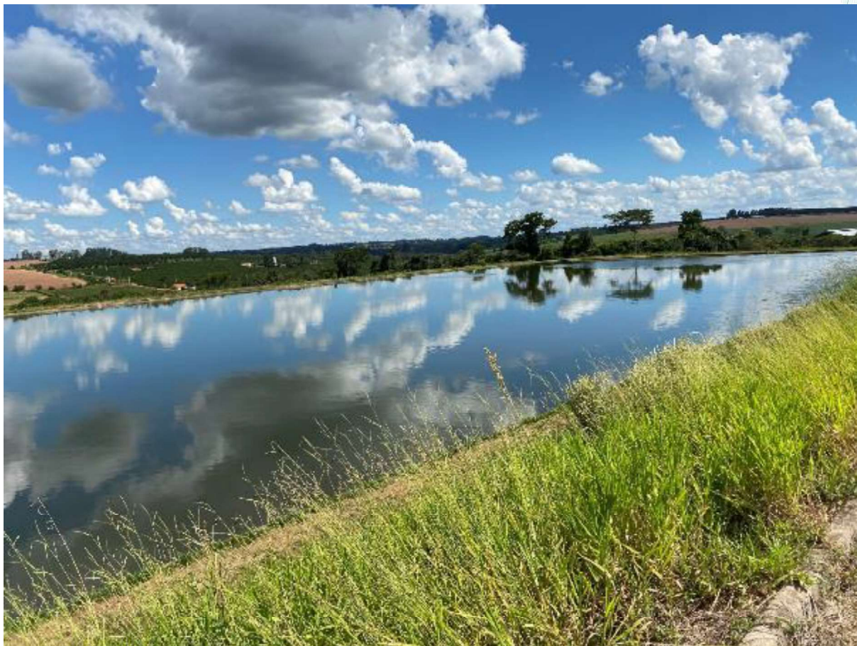
Figura 102 – Vista de uma das duas lagoas facultativas fotossintéticas
