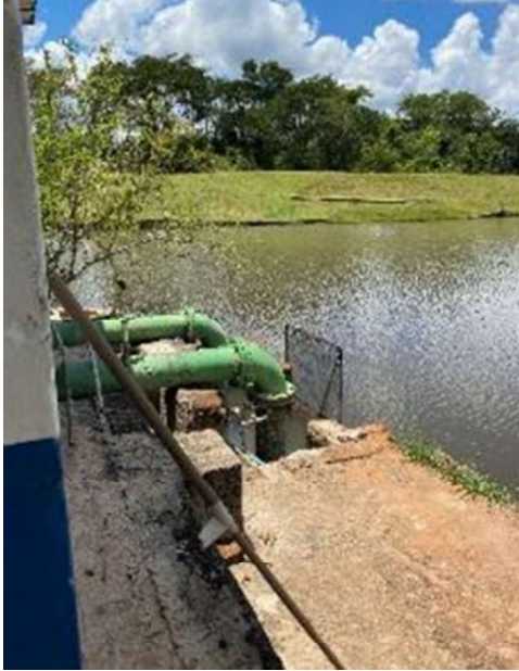
Figura 64 - Tomada d'água
