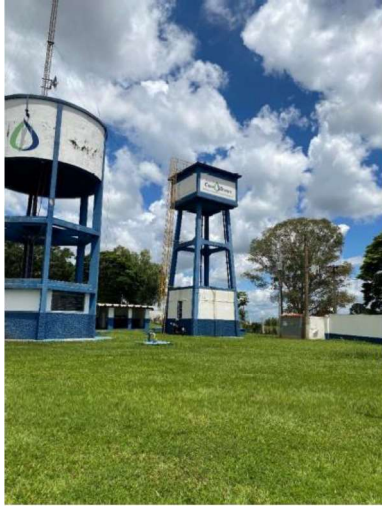
Figura 85-Reservatório ETA I
