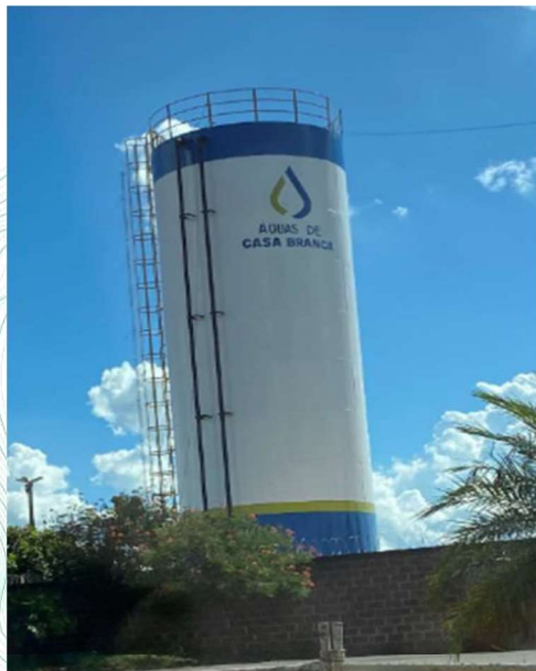
Figura 89- Reservatório Jardim Monte Belo 1.
