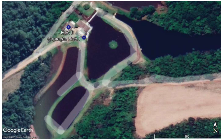
Figura 24 - Vista aérea do local da captação para as ETA's 01 e 02 e da ETA -02.
