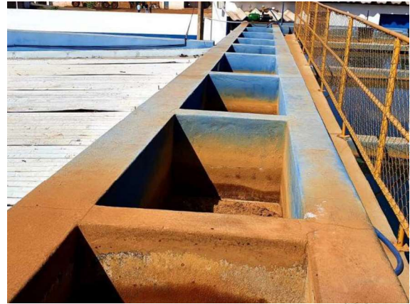
Figura 53 - Flocladores de chicanas verticais reformados.
