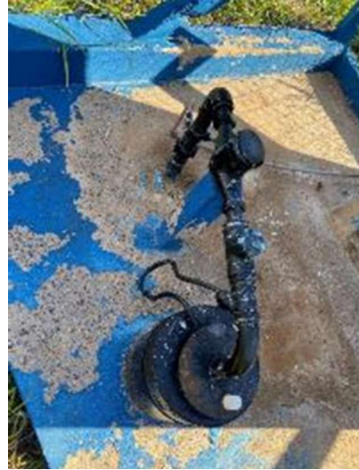
Figura 42 - Poço Bela Vista
