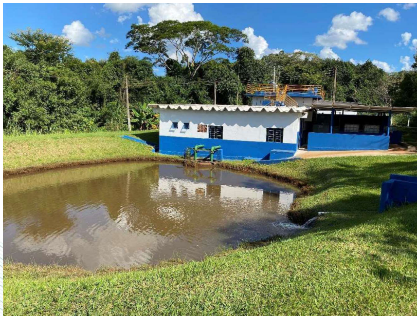
Figura 28 - Tomada d'água - ETA – 3.
