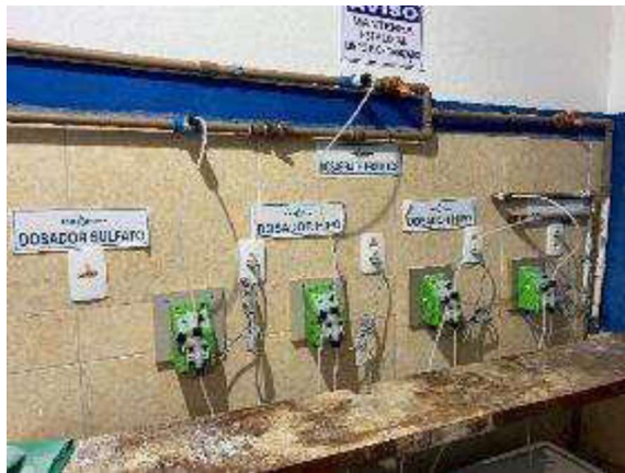
Figura 60 - Dosagem de aditivos e desinfetantes
