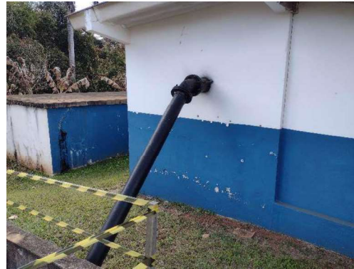
Figura 71- Início da adutora.
