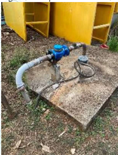
Figura 33- Afloramento do poço Nazaré – situado na ETE – 1
