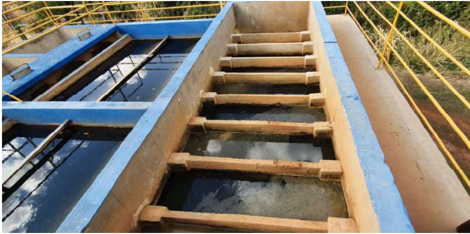
Figura 76 – Flocculador.
