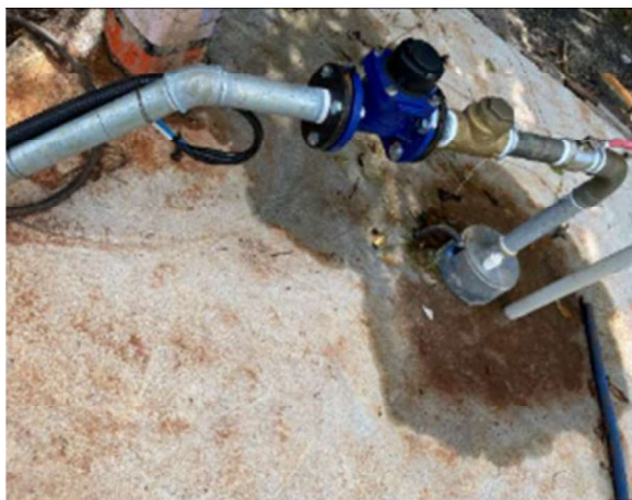
Figura 31 - Poço situado na ETA 3
