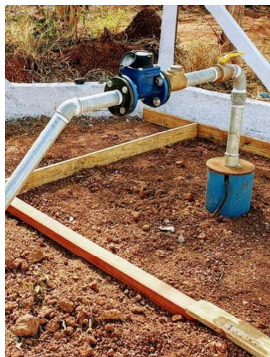
Figura 46 - Poço da ETA
