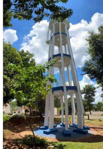
Figura 86 - Reservatório elevado situado na empresa ROHR
