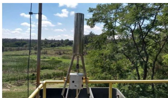
Figura 107 – Flare para queima dos gases gerados no processo
